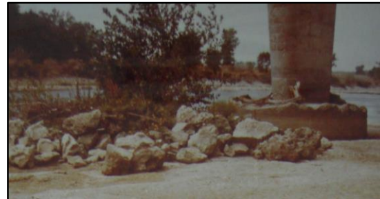
Affouillement pile de pont (Beaudelin)
