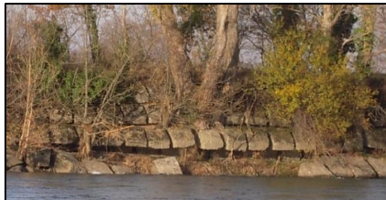
Déstabilisation enrochement (Jantzi)
