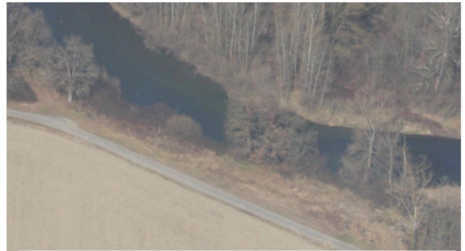
Déplacement de la route sur quelques mètres
